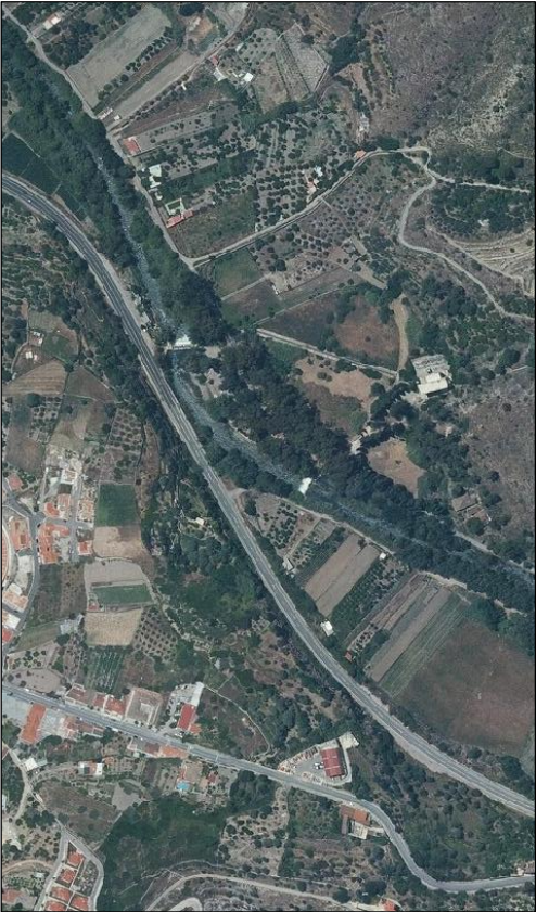
Imagen 27: Cauce natural a la altura del PK 3+100 (playa de Benaudalla) sobre ortofoto de 2010
