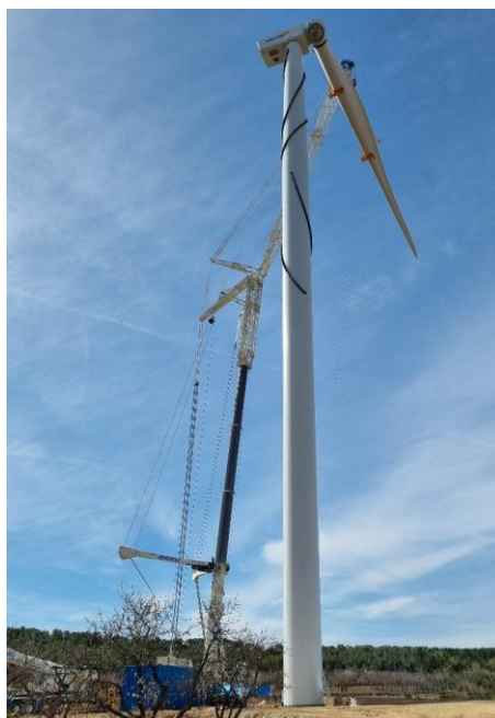
Figura 21. Grúa de montaje principal en el proceso de instalación de una pala.
