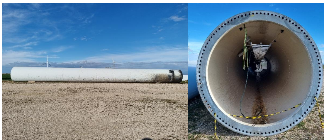
Figura 4: Vista lateral y superior tramo de torre de un aerogenerador.
