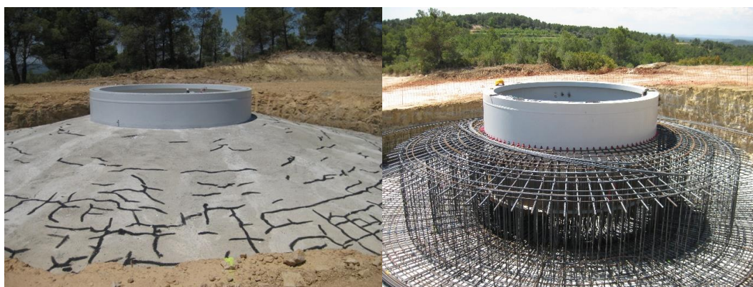
Figuras 5 y 6: cimentación aerogenerador con hormigonado terminado y vista del armado.
