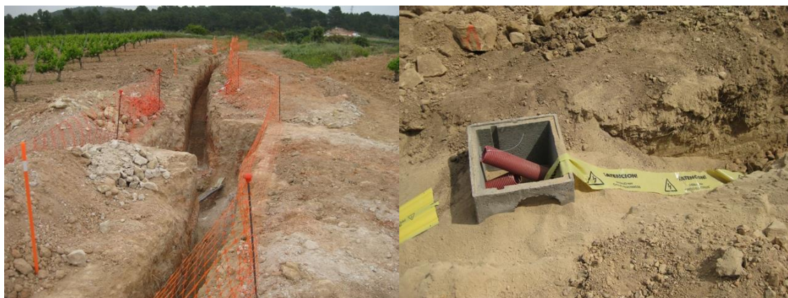
Figura 9. Zanja para cables y arqueta de unión.
