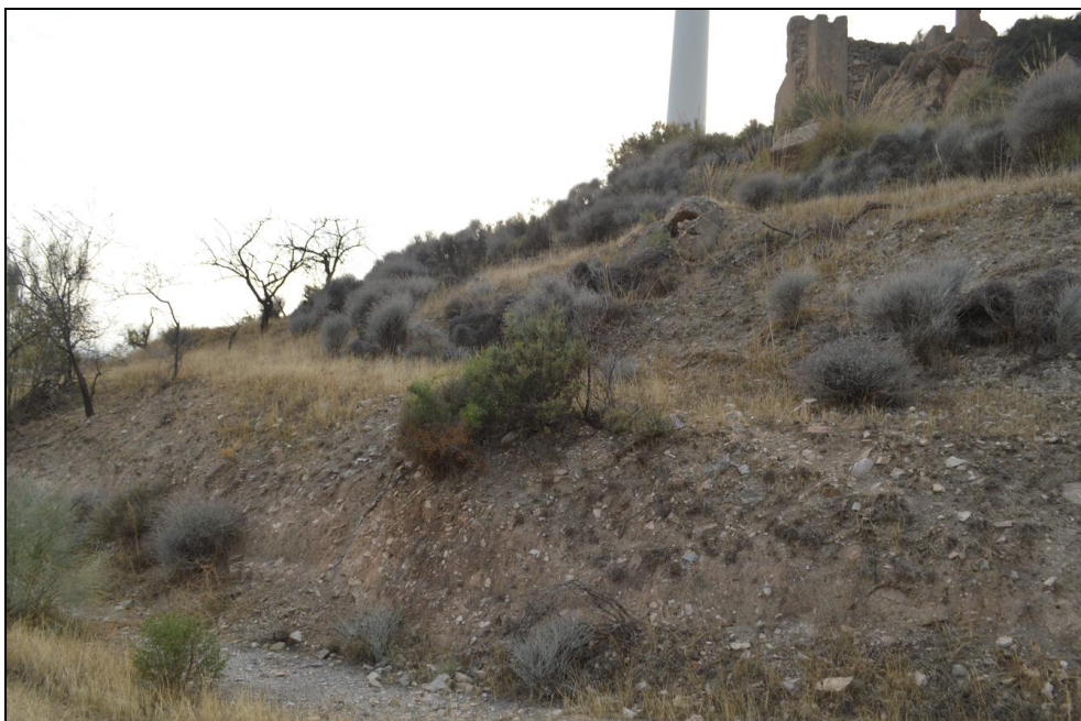
Fotografía 2. Materiales coluviales en el futuro emplazamiento del aerogenerador LO-04
