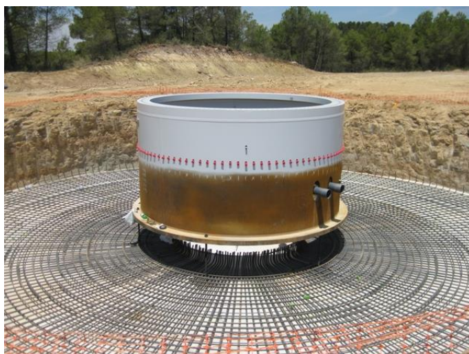
Figura 7: tramo unión torre con cimentación, jaula de pernos.
