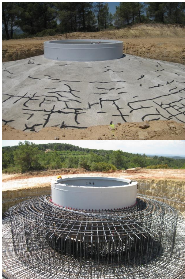
Figuras 5 y 6: cimentación aerogenerador con hormigonado terminado y vista del armado.
