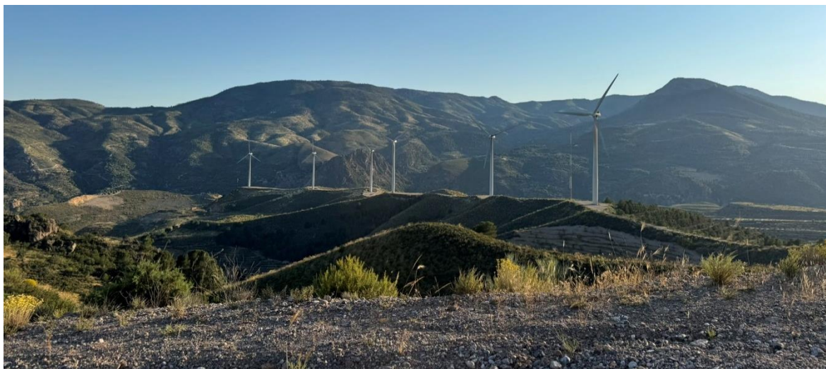
Fotografía 1. Aerogeneradores del 1 al 6
