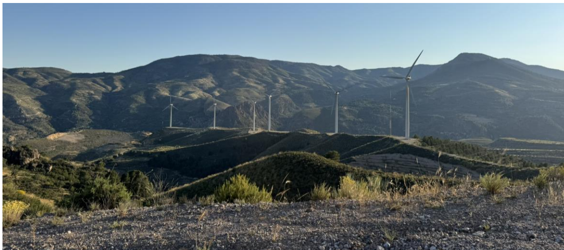
Fotografía 1. Aerogeneradores del 1 al 6
